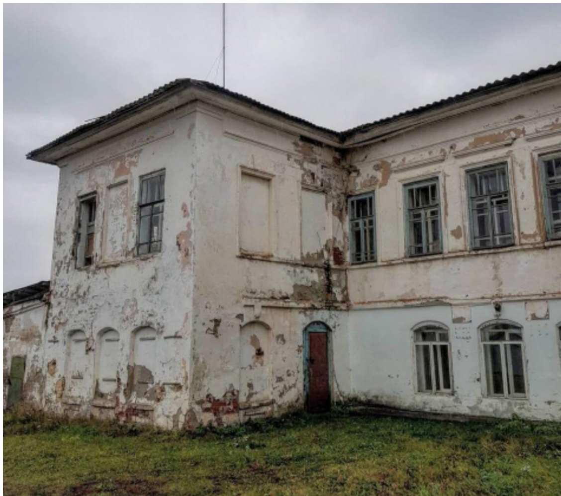
Фото 2. Вид с севера. Примыкание флигеля к главному дому
