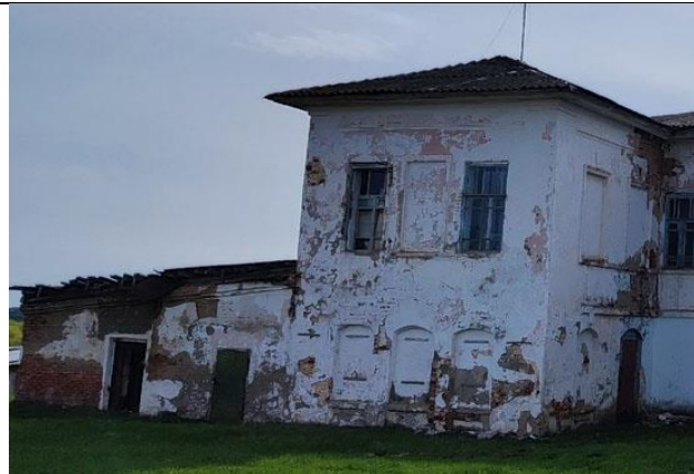
Вид с северо-востока
