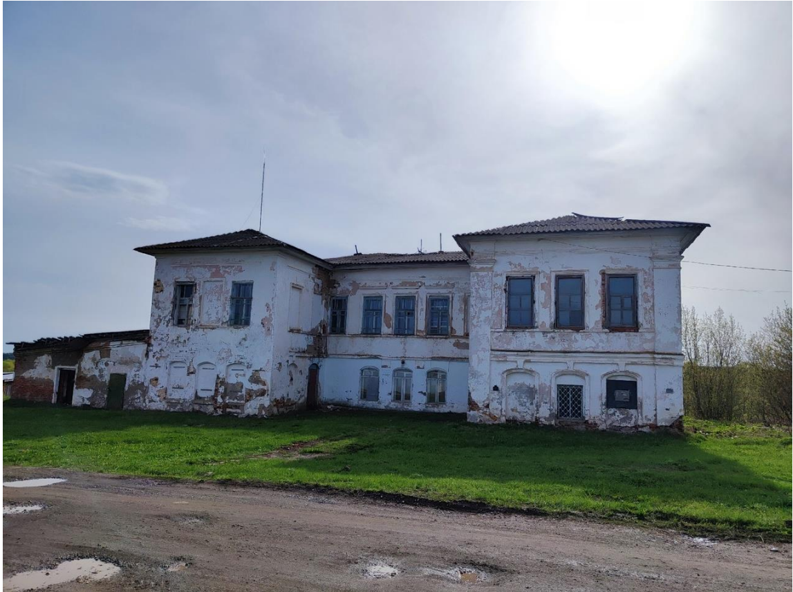
Фото 1. Вид с северо-востока
