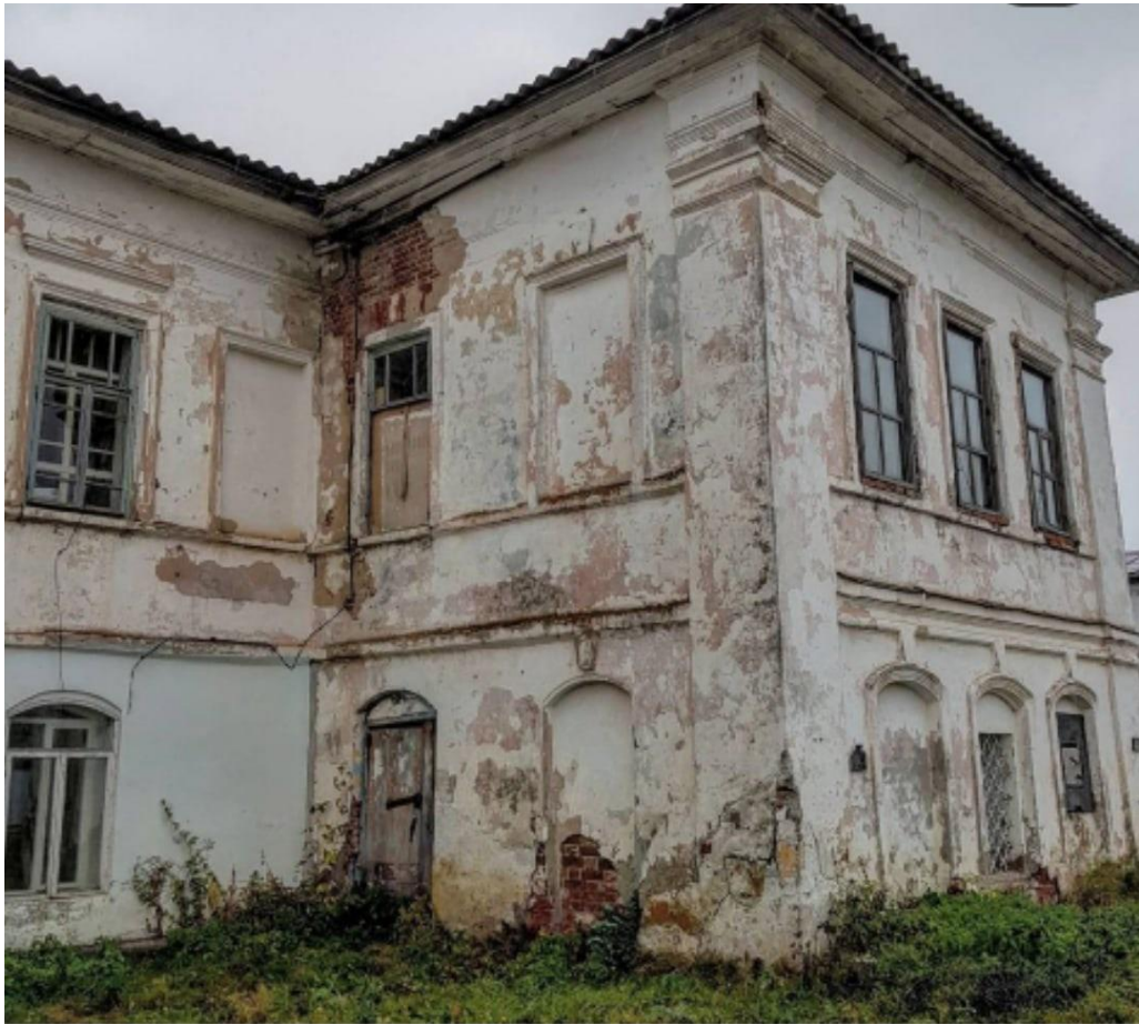
Фото 3. Вид с юго-востока. Видна кирпичная кладка второго этажа флигеля
