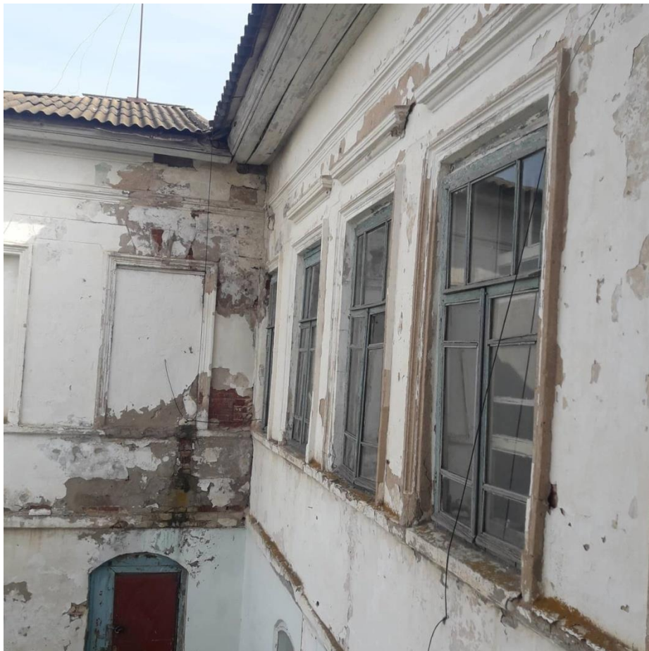
Фото 4. Вид с севера. Видна кирпичная кладка второго этажа флигеля
