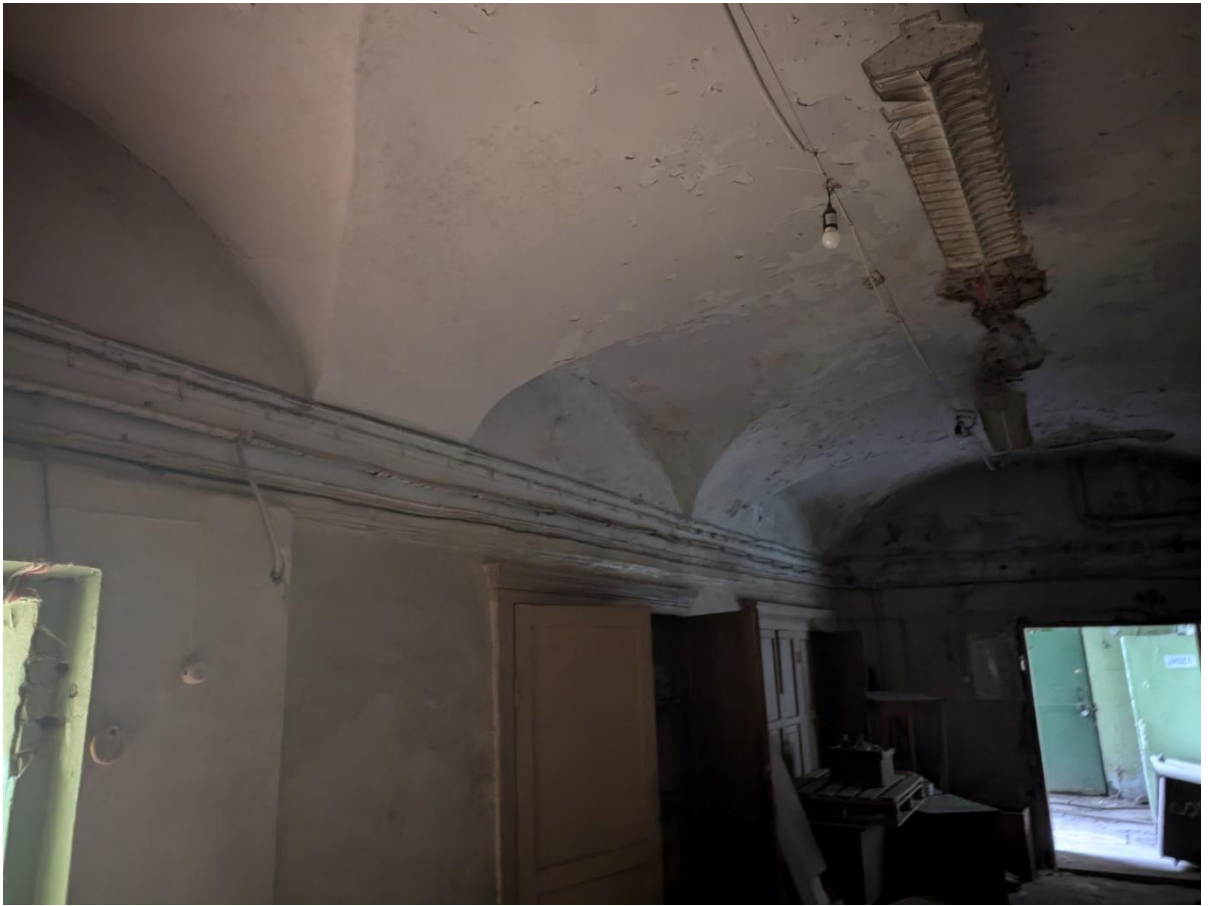
Кадр 5. Дата съемки: 16.08.2024. Подвальный помещение
