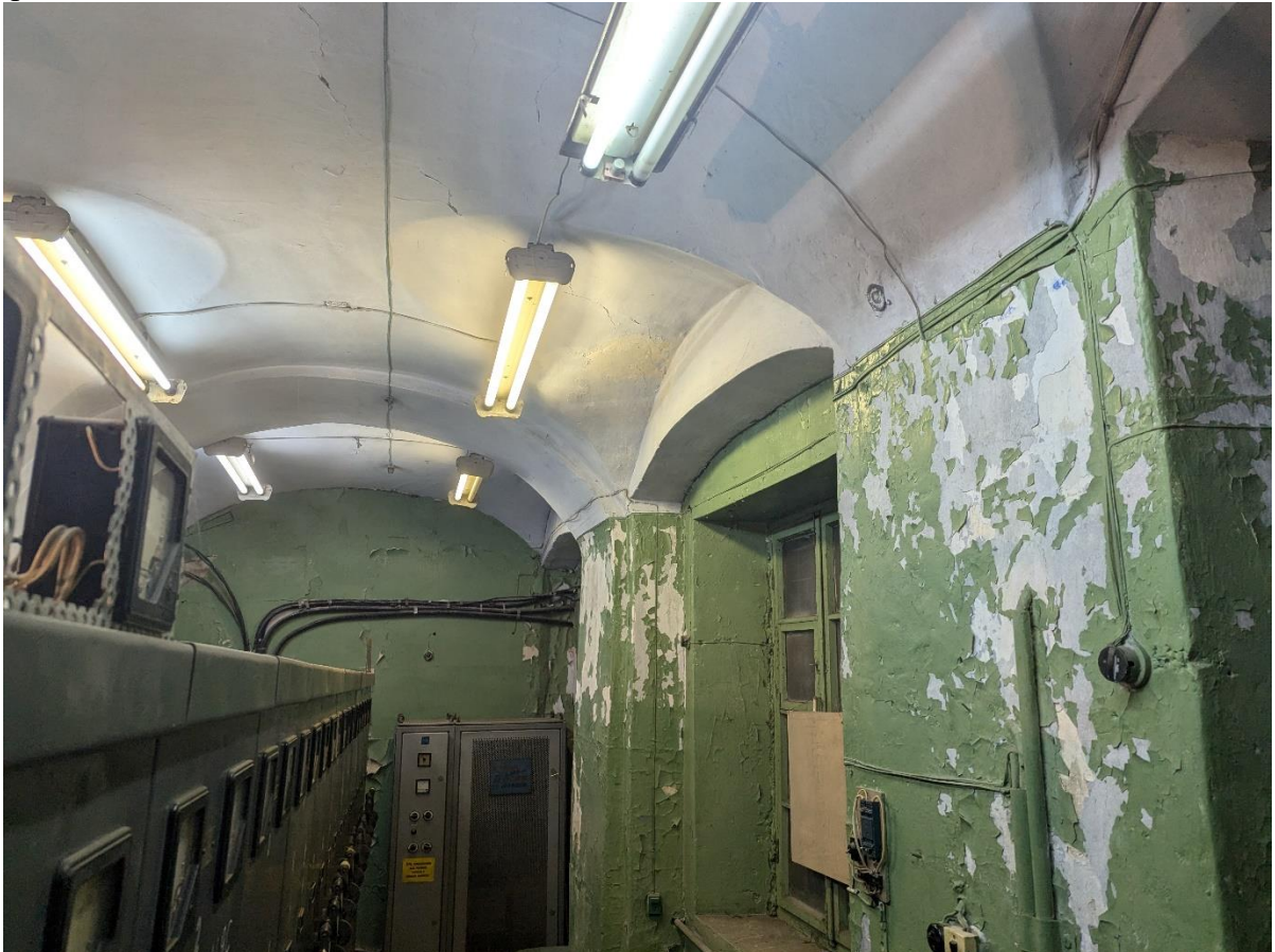
Кадр 4. Дата съемки: 16.08.2024. Подвальное помещение
