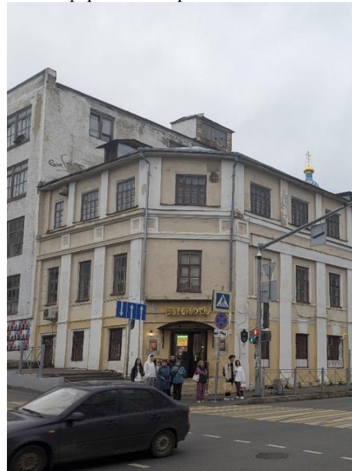
Фрагмент фасада по ул. Чернышевского, угловой ризалит (карнизы лопатками с декоративными вертикальными выступающими элементами)
