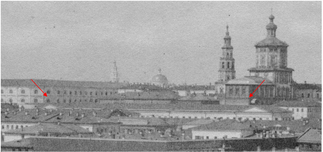
Рис.11 Фрагмент фотографии 1879 г. Видна крыша, фрагмент портика и часть второго этажа Москательного ряда
