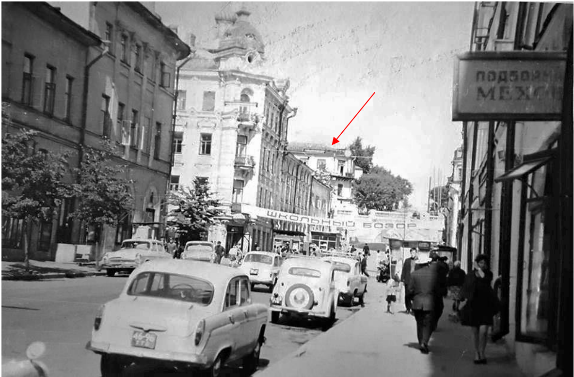
Рис.18 Фото 1960х гг. На дальнем плане виден надстроенный третьим этажом Москательный ряд
