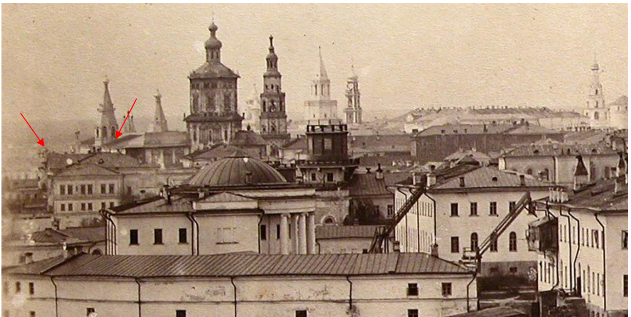
Рис.10 Фрагмент фотографии 1860х гг. Виден портик и фрагмент бокового фасада Москательного ряда
