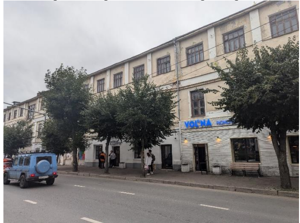
Фрагмент фасада по ул. Профсоюзная (центральная часть, карнизы)
