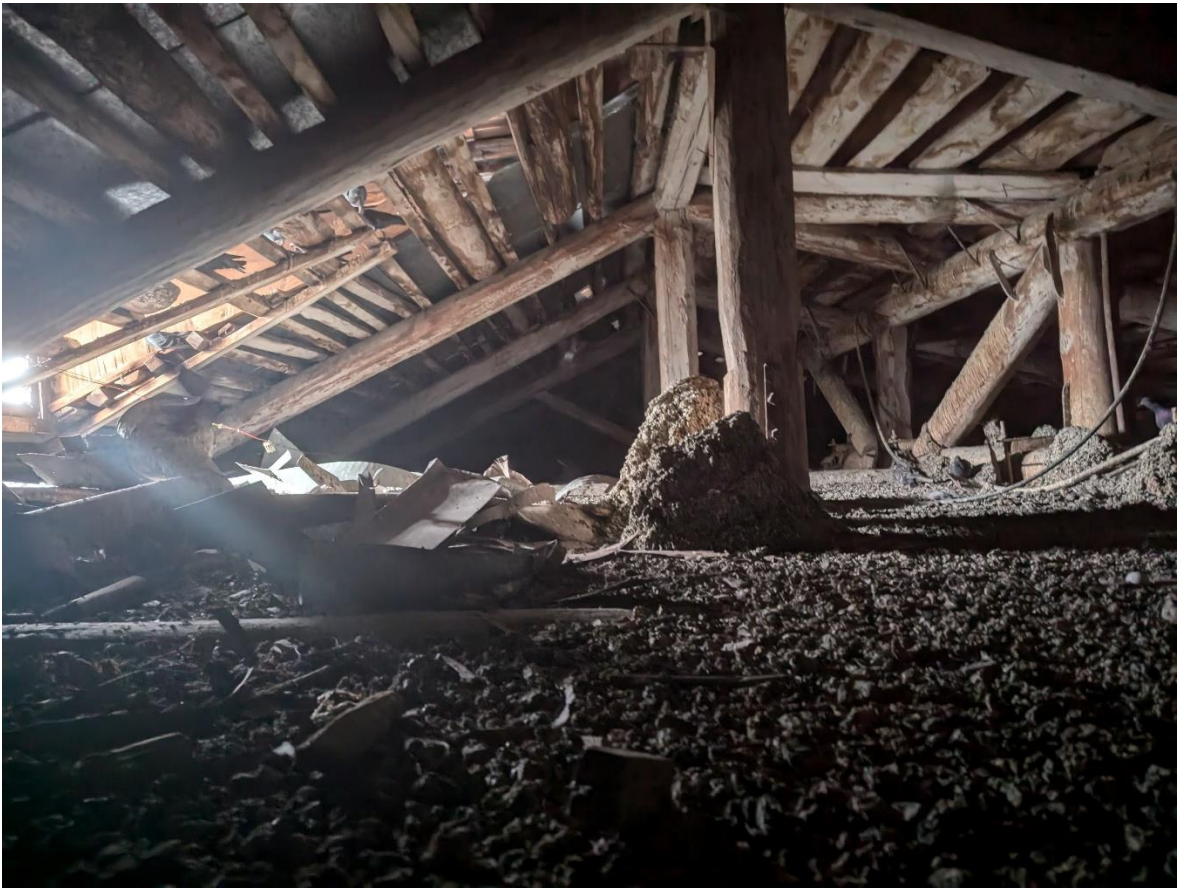
Кадр 1. Дата съемки: 16.08.2024. Чердачное помещение
