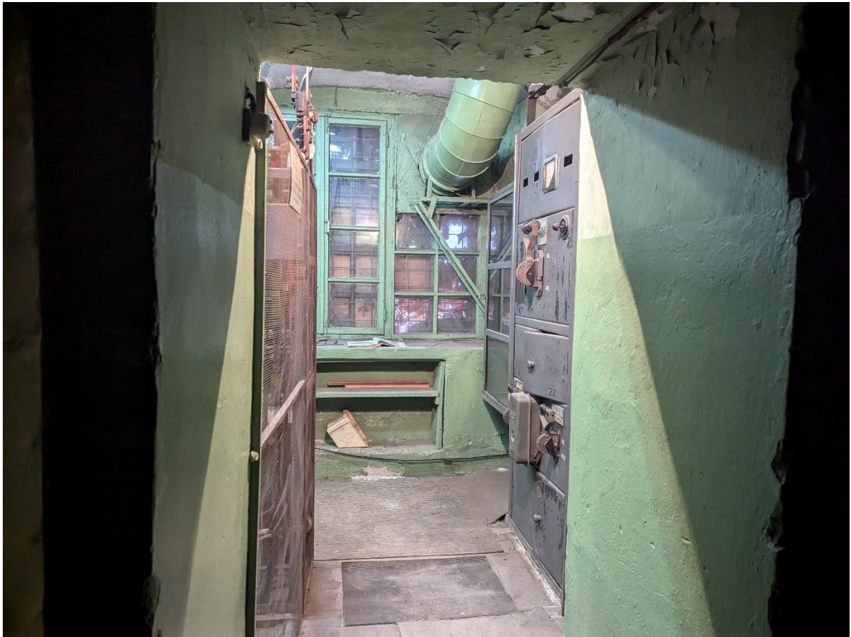
Кадр 3. Дата съемки: 16.08.2024. Подвальное помещение
