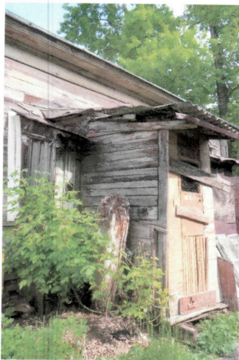
Кадр 7. Входной тамбур дворового (западного) фасада объекта
