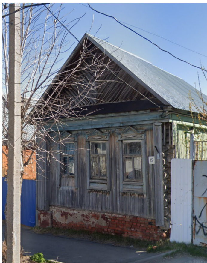
Жилой дом по ул. Ленина.
