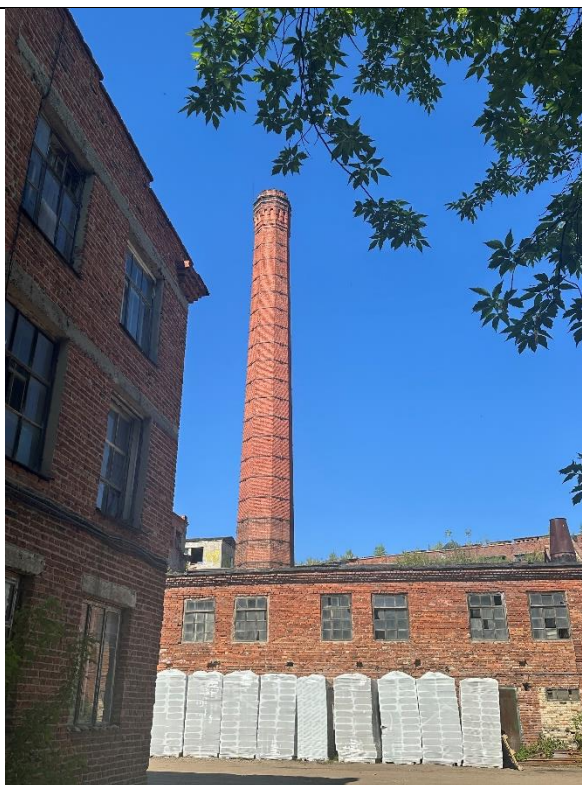
Ствол трубы с оголовком
