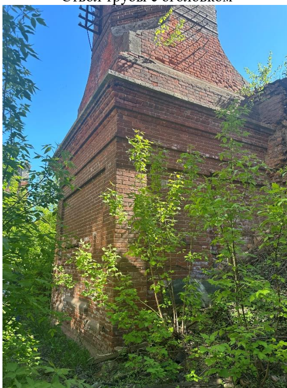
Цокольная часть трубы
