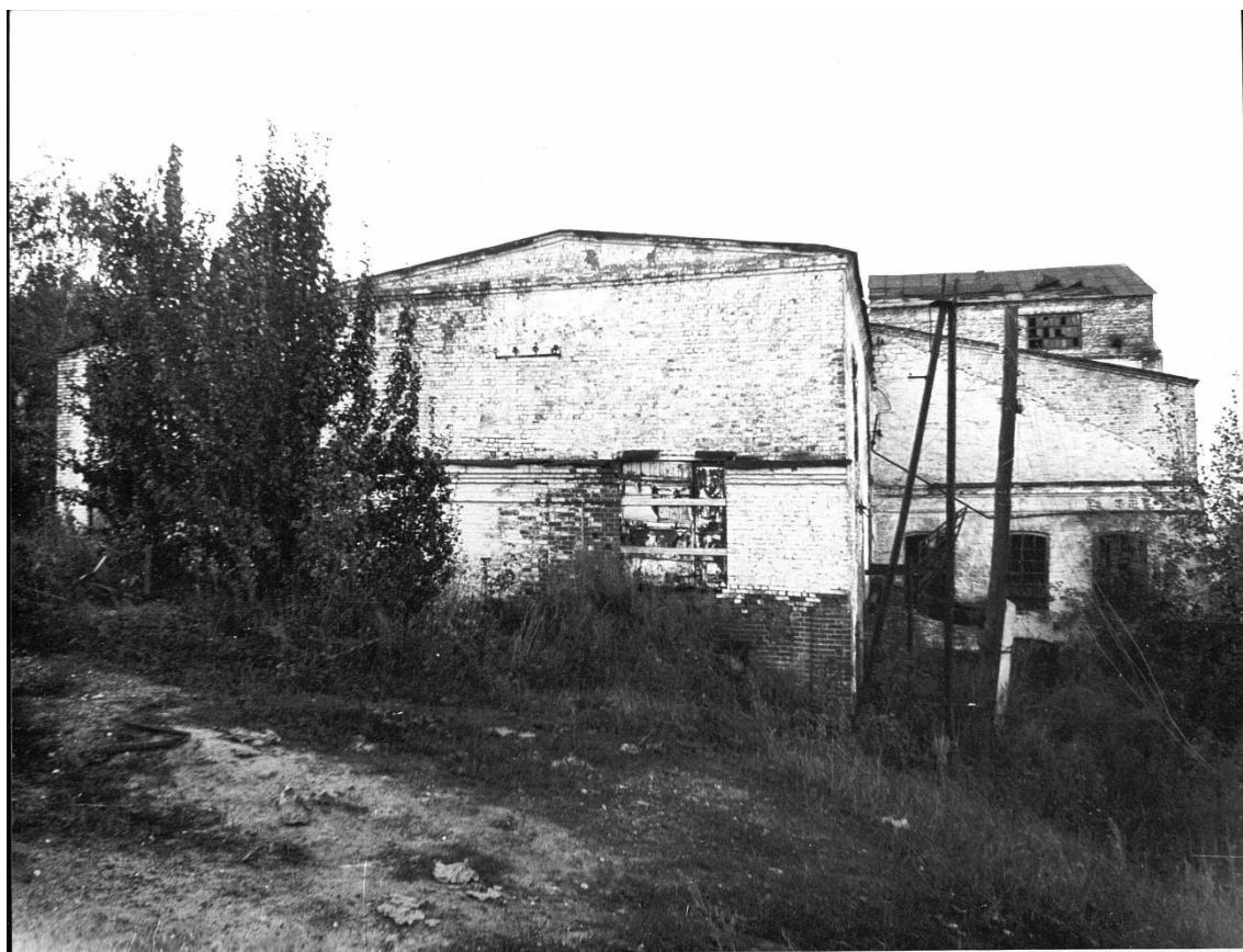
Рис. 10. Фото утраченного здания спиртового завода. 1999 г
