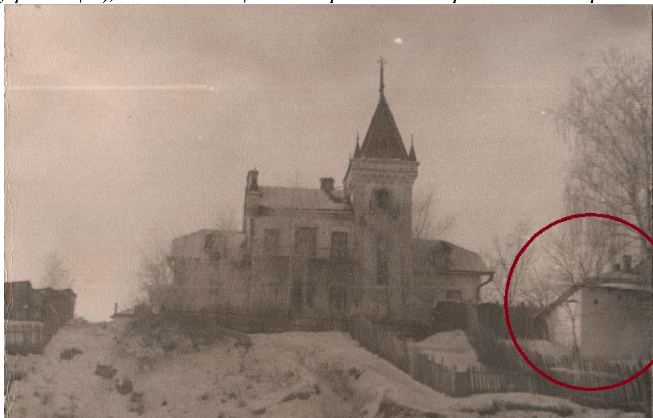
Рис. 6. Заводская контора (Дом управляющего) Гребеневского спиртзавода. На переднем плане торец здания Каменного подвала для хранения спирта. Фото сер. XX в.
