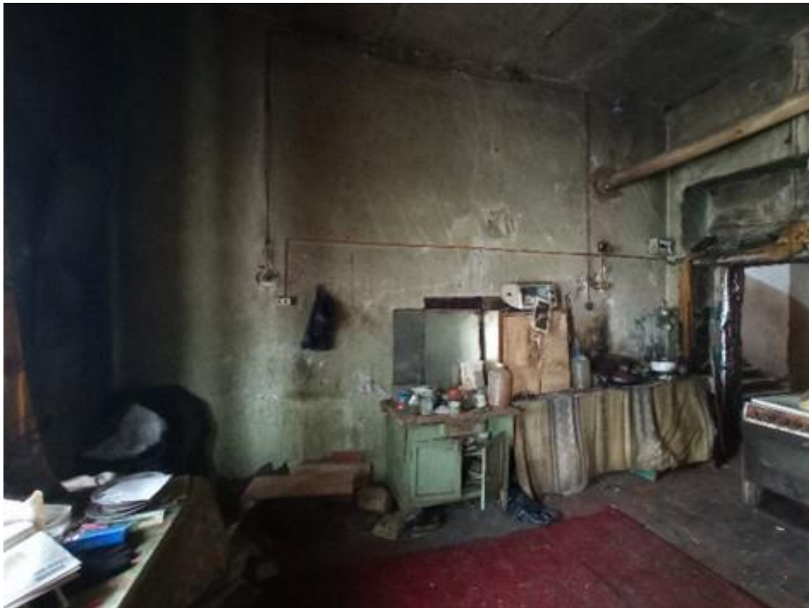
Кадр 14. Помещение 1 этажа. Дата съемки: 03.02.2023
