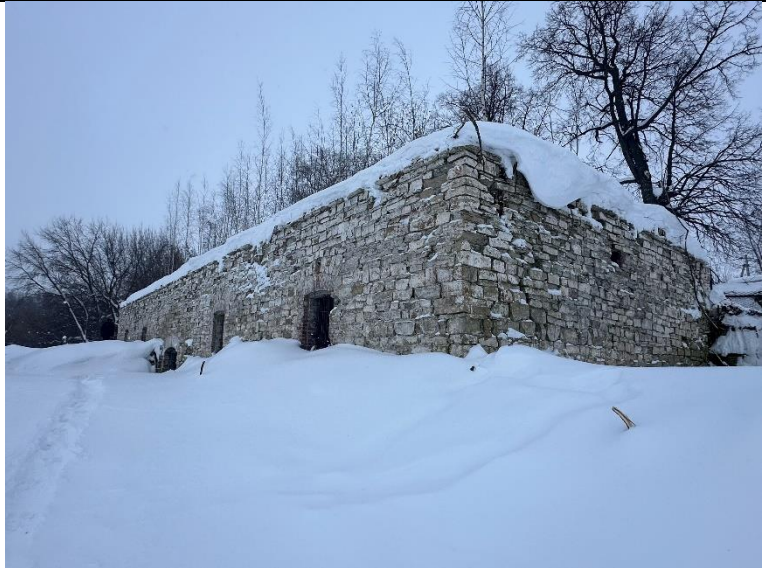
Общий вид с северной стороны
