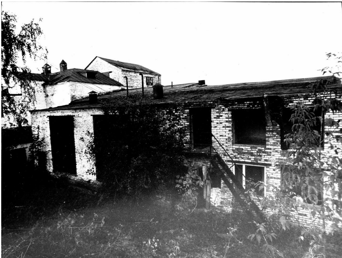
Рис. 13. Фото утраченного здания спиртового завода. 1999 г
