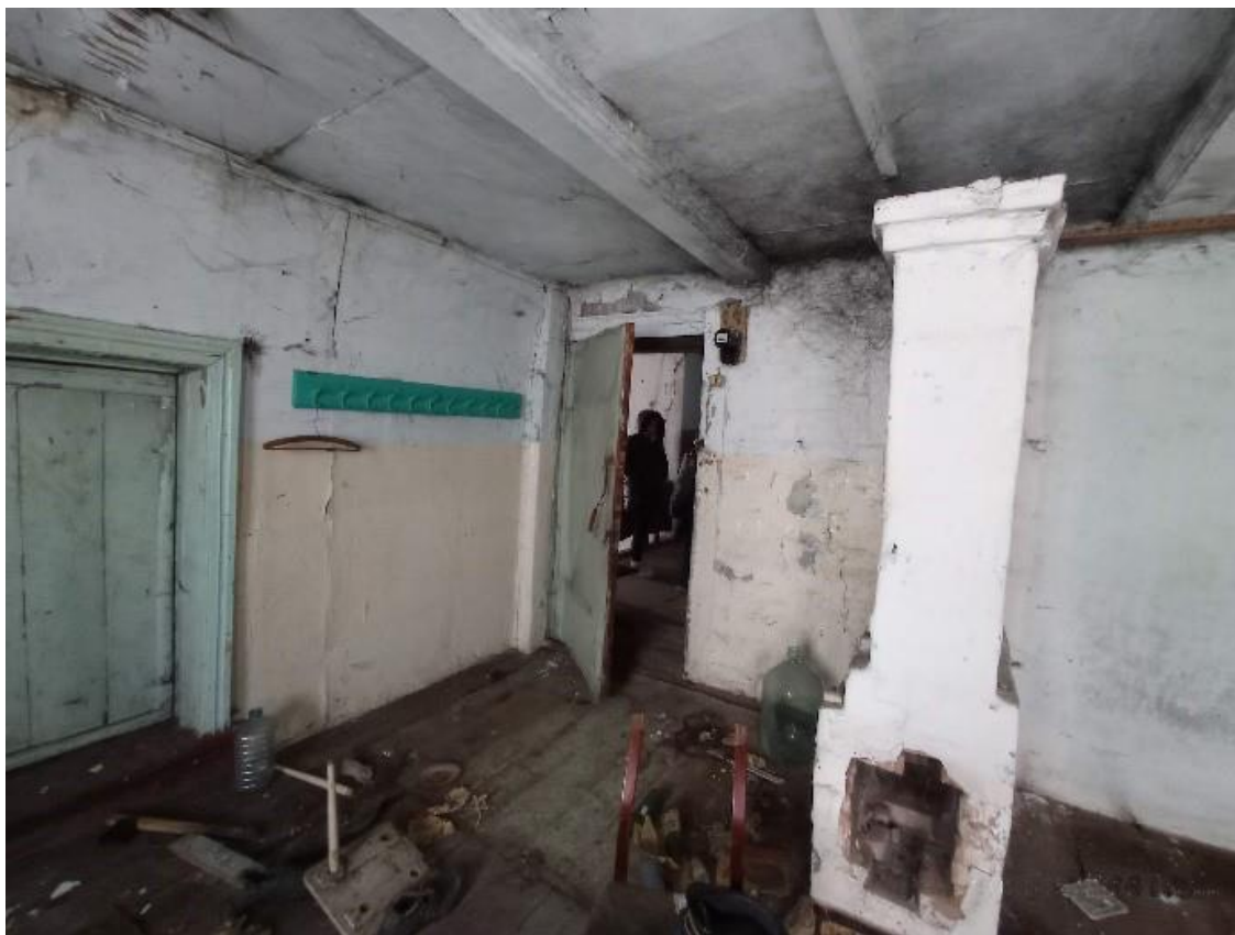
Кадр 19. Помещение антресольного этажа. Дата съемки: 03.02.2023
