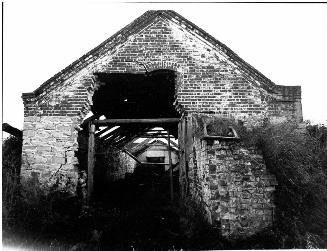
Рис. 11. Фото утраченного здания спиртового завода. 1999 г
