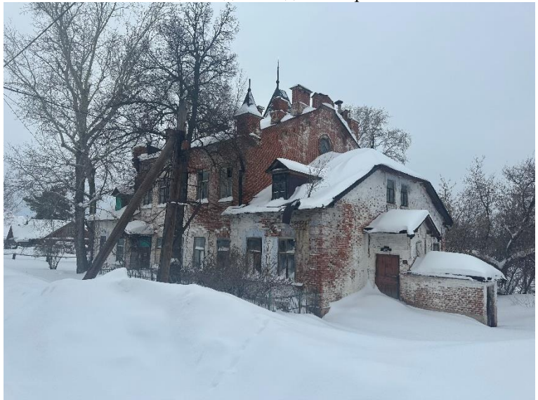
Общий вид с южной стороны
