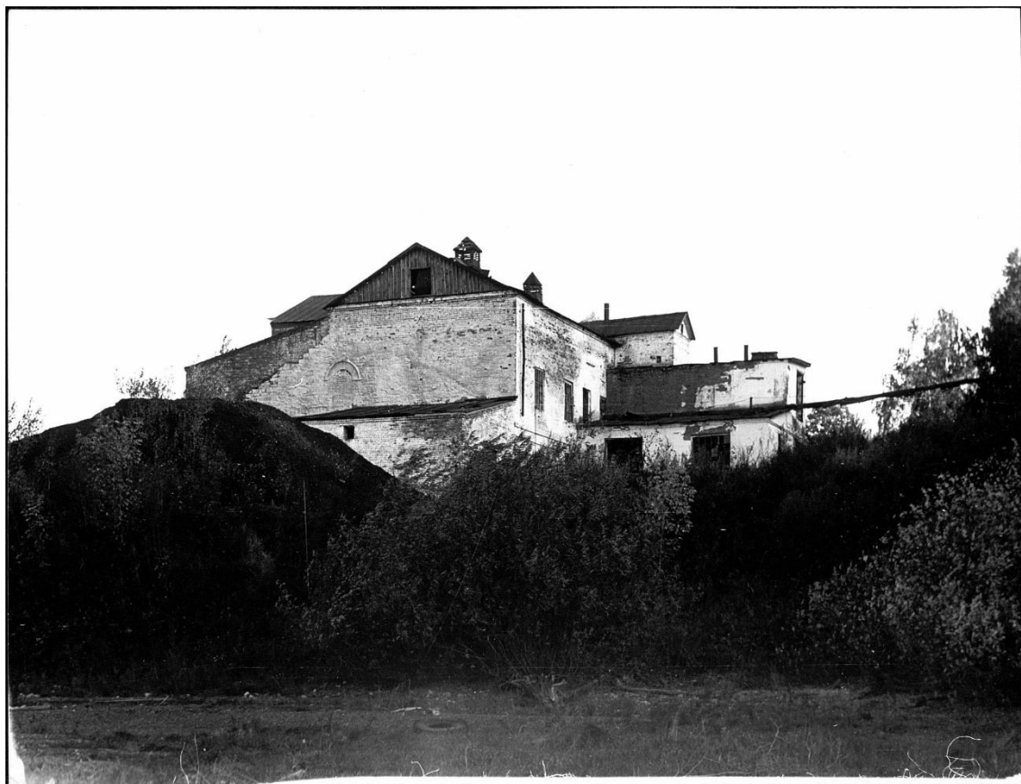
Рис. 9. Фото утраченного здания спиртового завода. 1999 г
