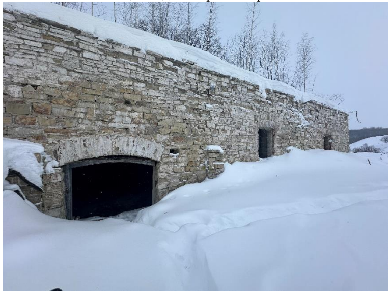
Общий вид с северо-восточной стороны
