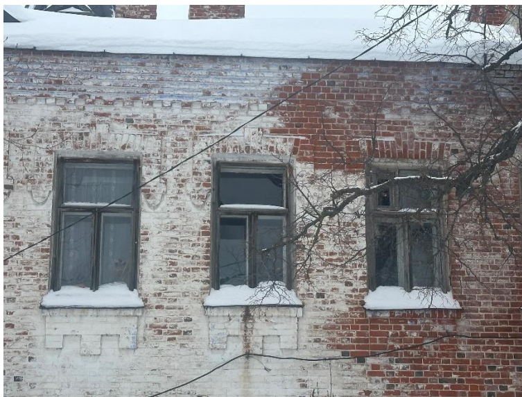
Оконные проемы второго этажа
