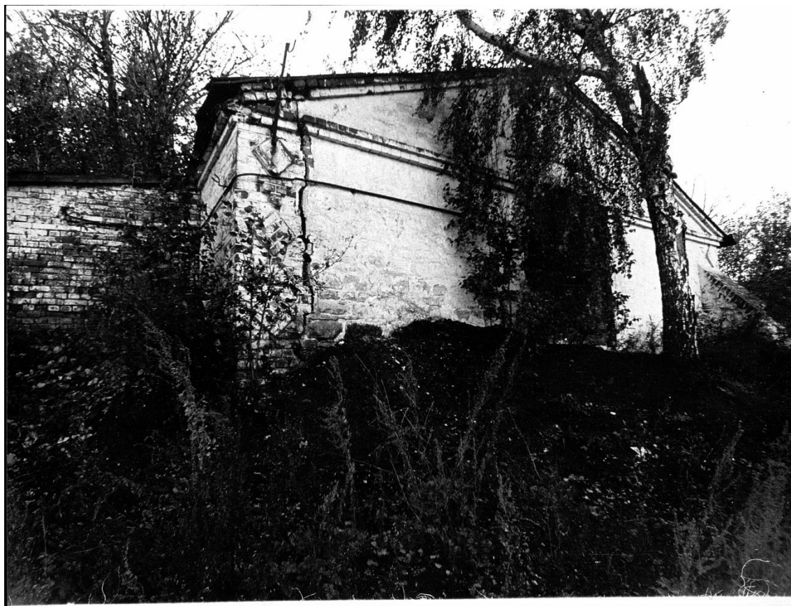
Рис. 12. Фото утраченного здания спиртового завода. 1999 г
