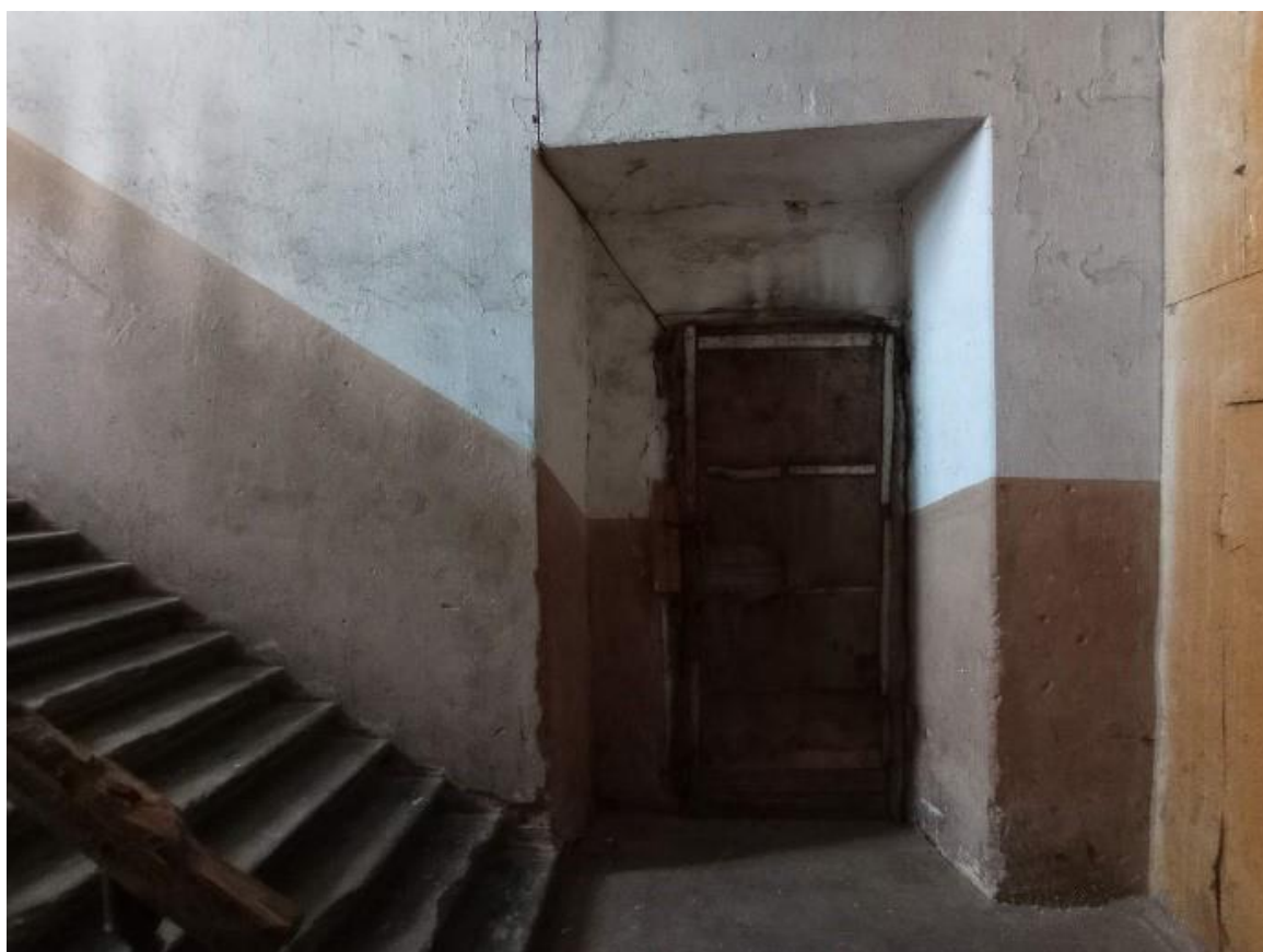
Кадр 18. Лестничная клетка. Дата съемки: 03.02.2023
