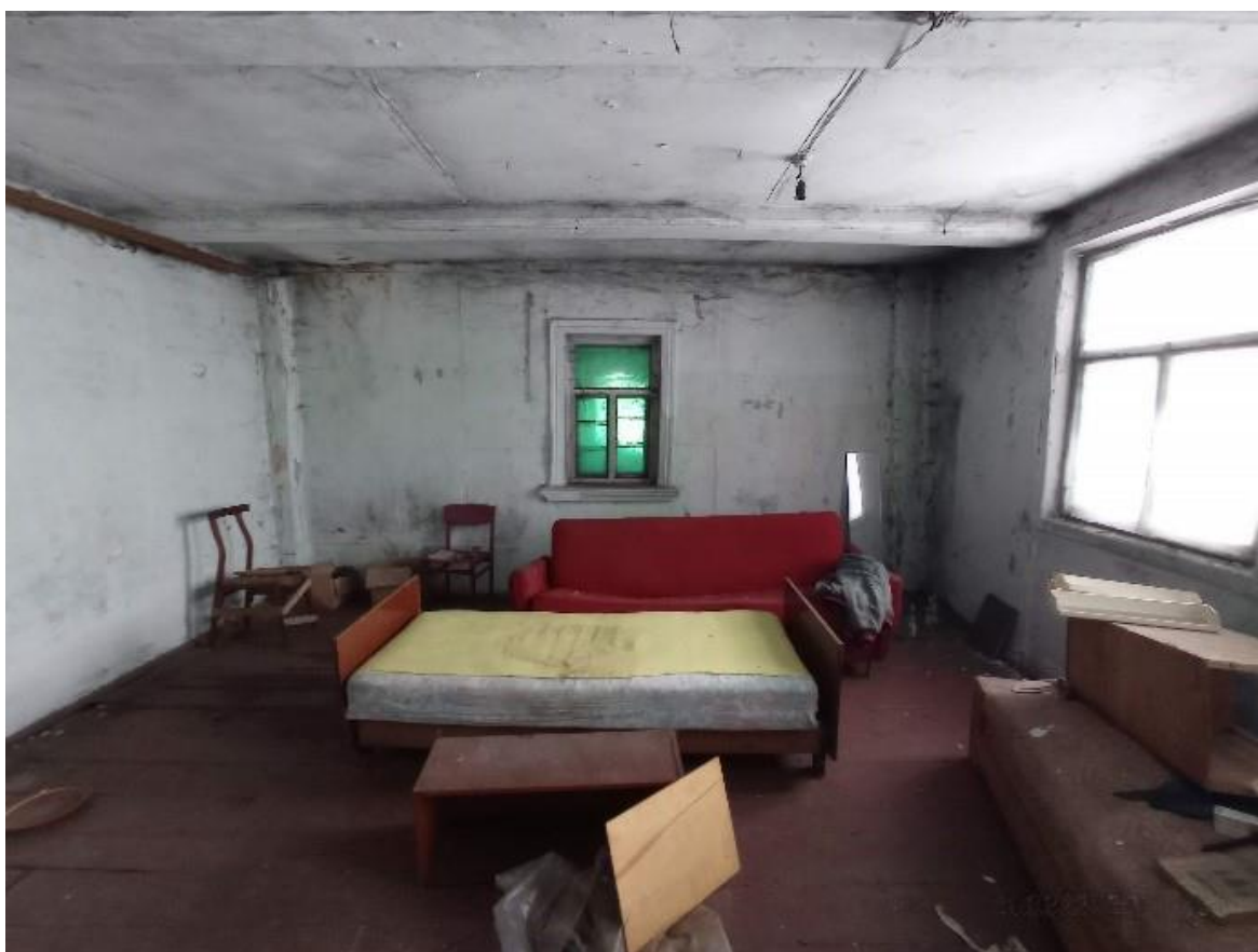
Кадр 20. Помещение антресольного этажа. Дата съемки: 03.02.2023
