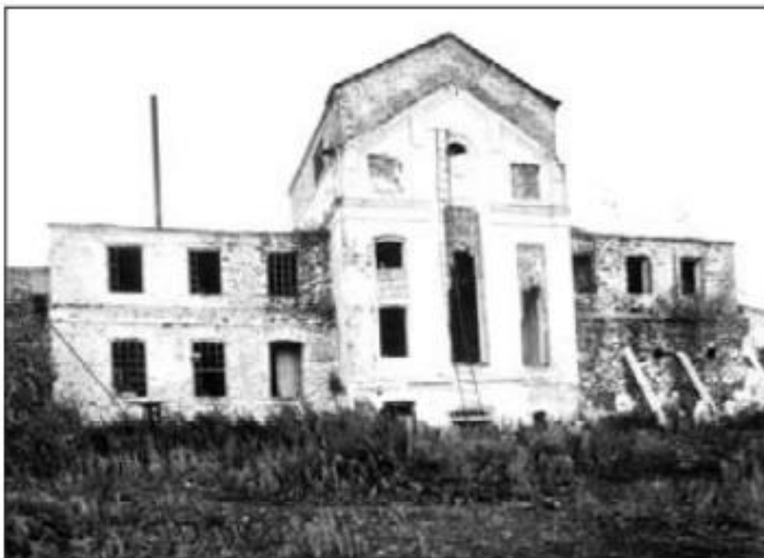
Рис. 7. Фото утраченного здания спиртового завода. 1999 г
