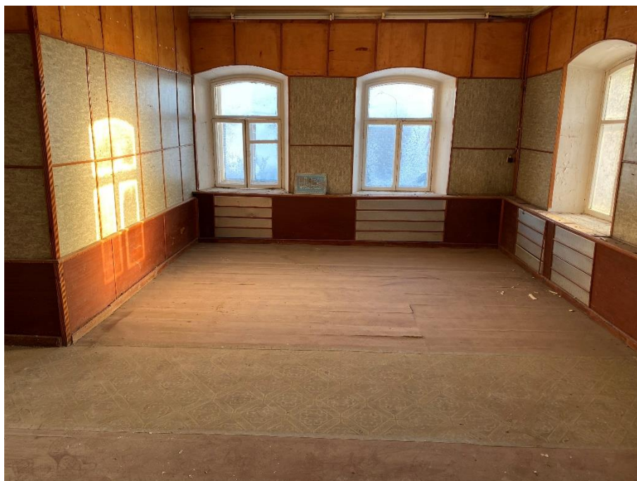
Кадр.№24 Помещение 2-го этажа Дата съемки: декабрь 2022 г
