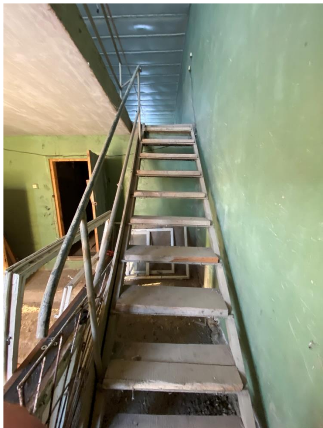
Кадр №15 Новая лестница на второй этаж. Дата съемки: декабрь 2022 г
