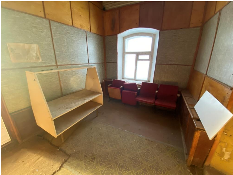
Кадр.№21 Помещение 2-го этажа. Дата съемки: декабрь 2022 г
