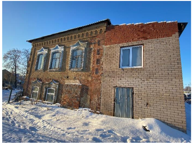
Общий вид торцевого дворового фасада
