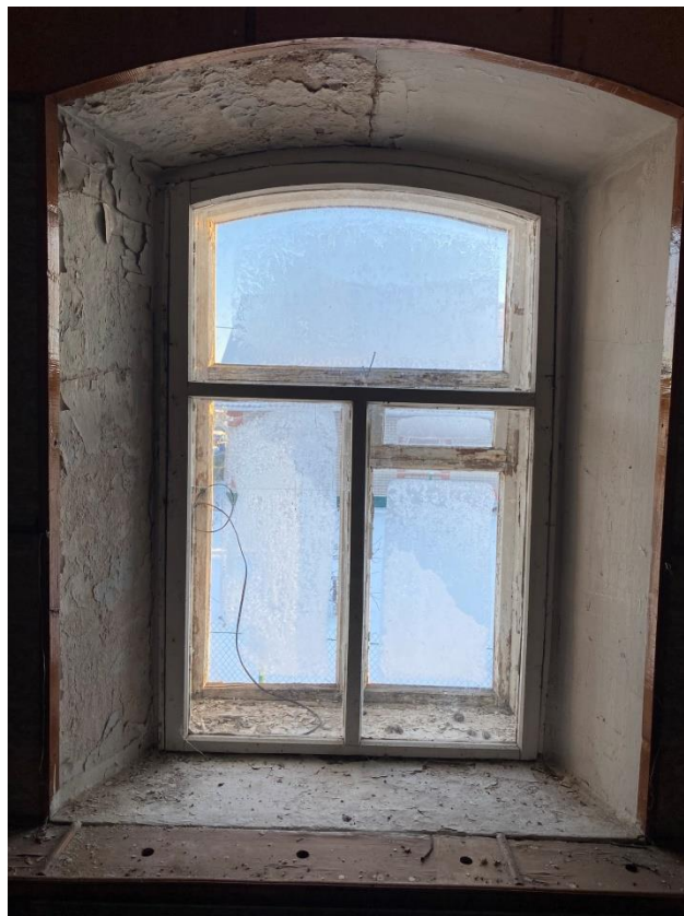
Кадр.№26 Помещение 2-го этажа Дата съемки: декабрь 2022 г
