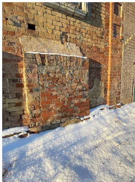
Фрагмент торцевого дворового фасада. Местоположение, габариты дверного проема
