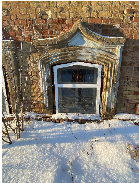
Фрагмент торцевого дворового фасада. Оформление оконных проемов
