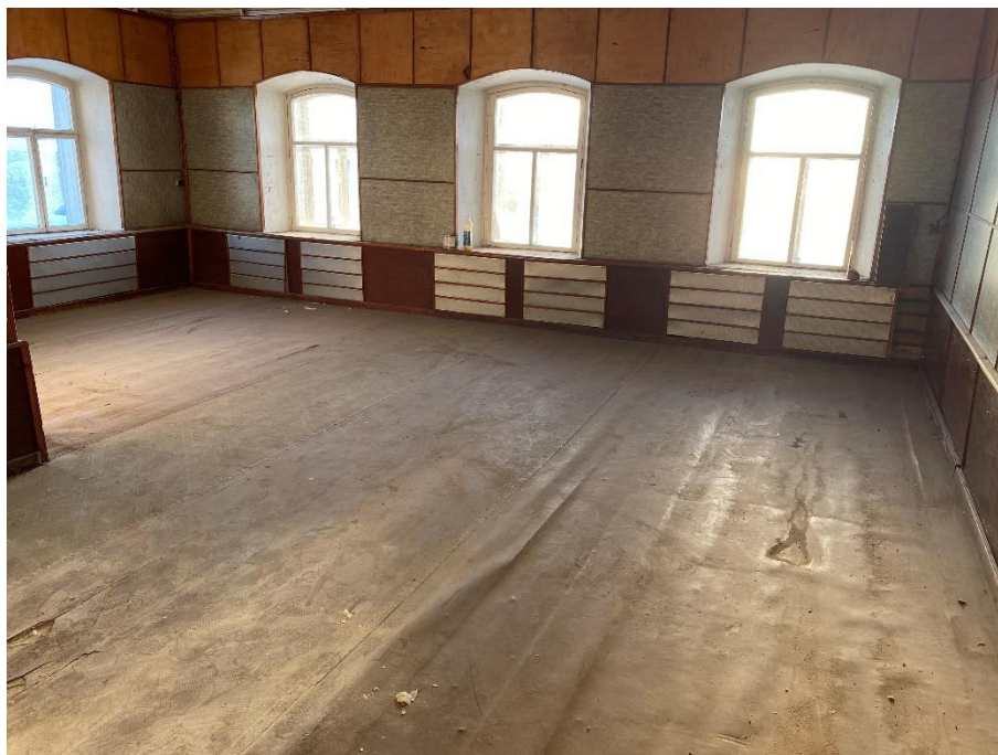
Кадр.№23 Помещение 2-го этажа Дата съемки: декабрь 2022 г
