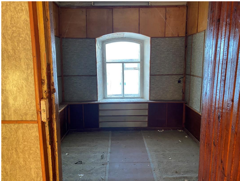
Кадр.№25 Помещение 2-го этажа Дата съемки: декабрь 2022 г
