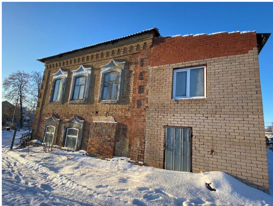
Кадр №7 Общий вид торцевого фасада Дата съемки: декабрь 2022 г
