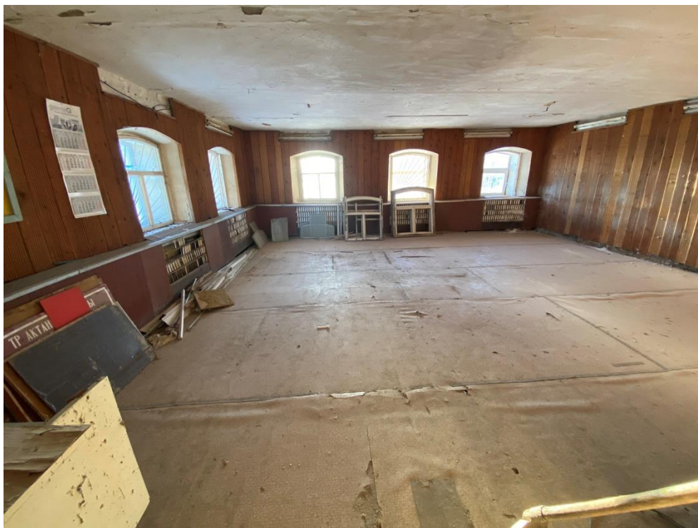
Кадр.№18 Помещение 1-го этажа Дата съемки: декабрь 2022 г
