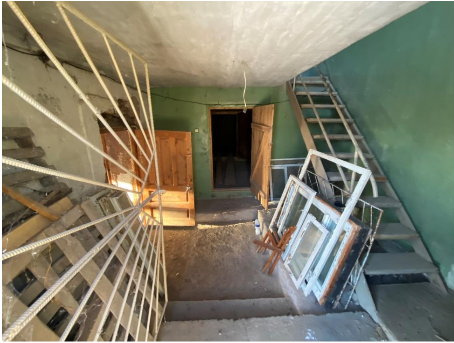
Кадр №14 Новая лестница на второй этаж Дата съемки: декабрь 2022 г
