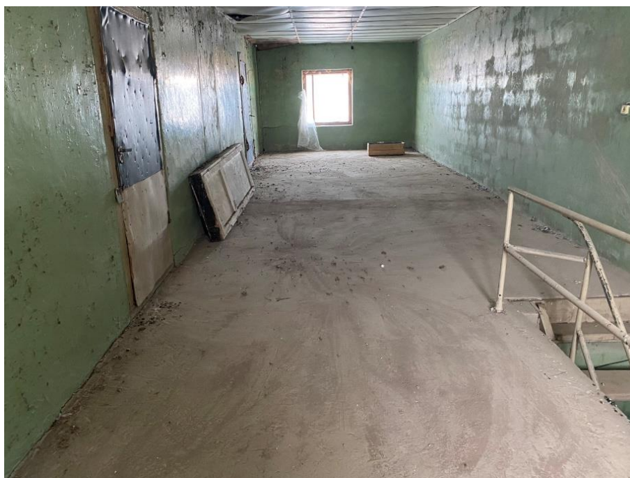
Кадр №20 Коридор 2-го этажа. Дата съемки: декабрь 2022 г
