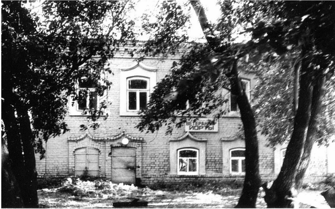
Рис.7 Общий вид главного фасада Фото 1999г.
