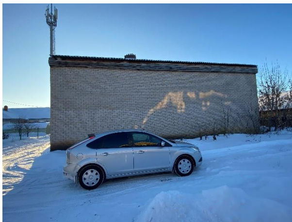
Общий вид со стороны заднего продольного фасада
