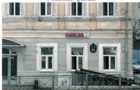
Оконные прямоугольные проемы 1 этажа в обрамлении рамочных наличников.
