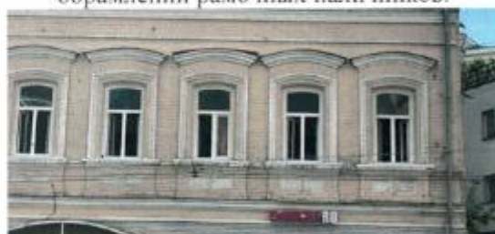
Оконные проемы 2 этажа с лучковыми перемычками и высокими сандриками.
