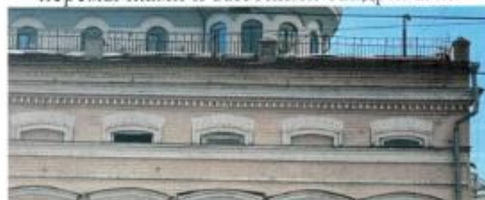
Щелевидные оконные проемы антресольного этажа, завершающий ступенчатый карниз с рядом сухариков, горизонтальные профили на уровне 2 этажа.
