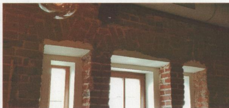
Кирпичные перемычки Подлинные кирпичные стены, кирпичные перемычки
