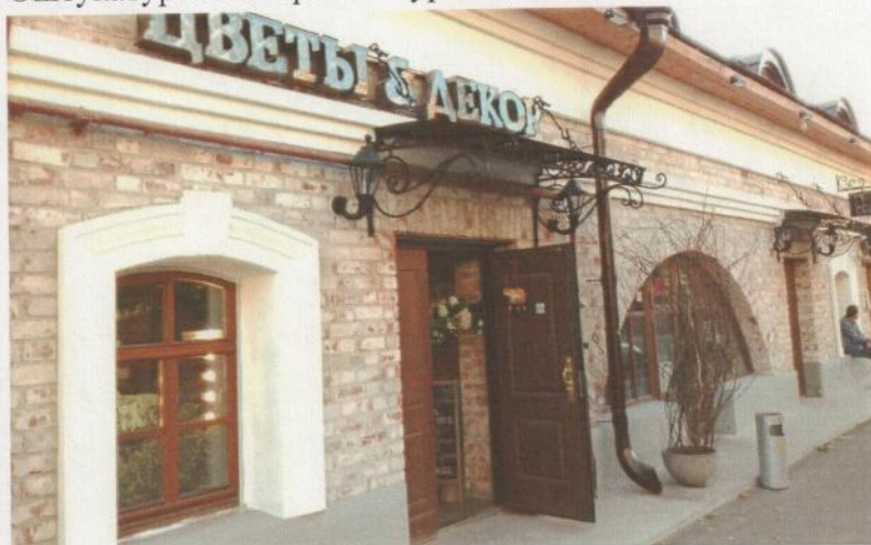
Оштукатуренные архитектурные детали
