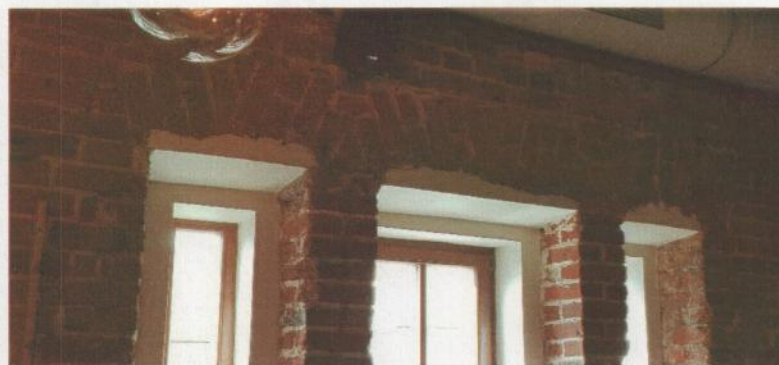
Кирпичные перемычки Подлинные кирпичные стены, кирпичные перемычки
