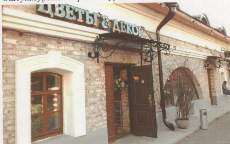
Оштукатуренные архитектурные детали
