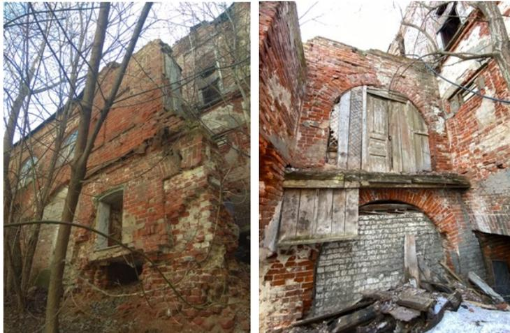
9 - историческое местоположение, геометрия и габариты исторических оконных и дверных проемов, материал заполнения – дерево.
