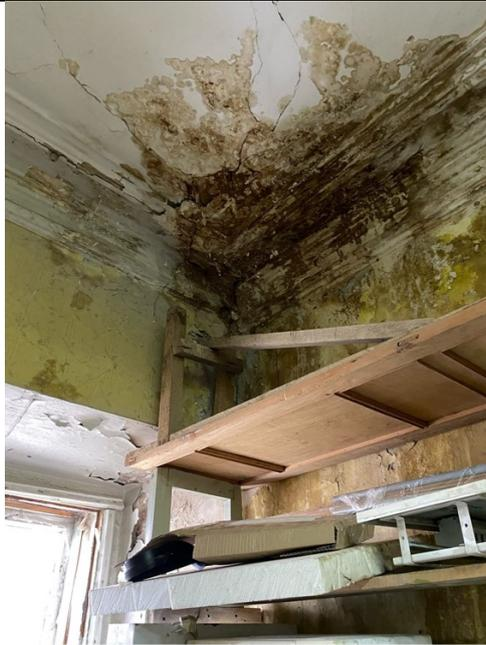
Рис. Потолочные тяги и следы намокания.
