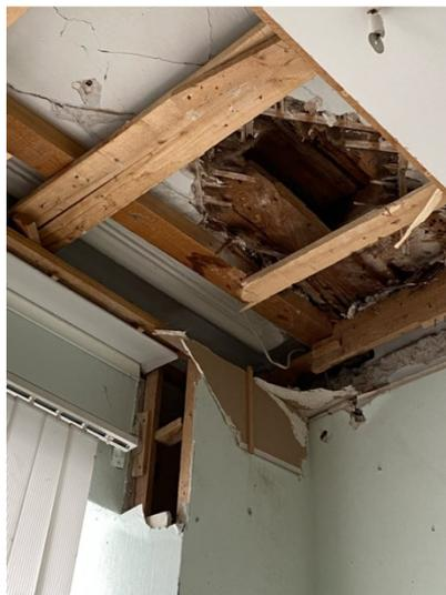
Рис. Деревянные конструкции перекрытия и потолочные тяги помещения №13.
