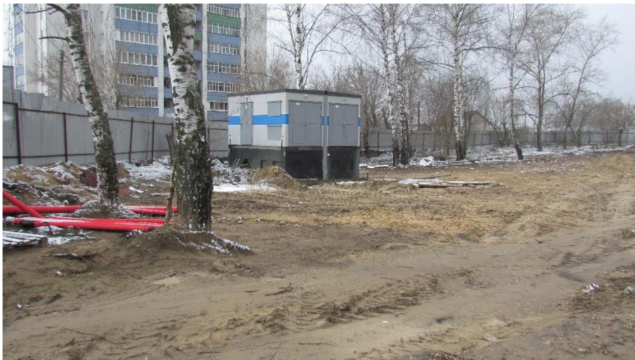
Рис.4. Фото участка обследования. Вид с северо-востока.
