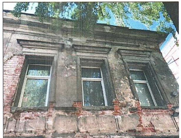
Оформление окон второго этажа, общий вид венчающего карниза
