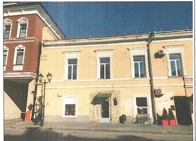
Фрагмент фасада по ул.К.Наджми
