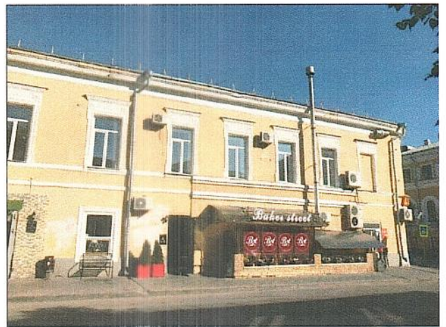
Фасад по ул. К.Наджми
