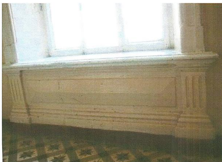
Убранство окна лестничной клетки между 1 и 2 этажами
