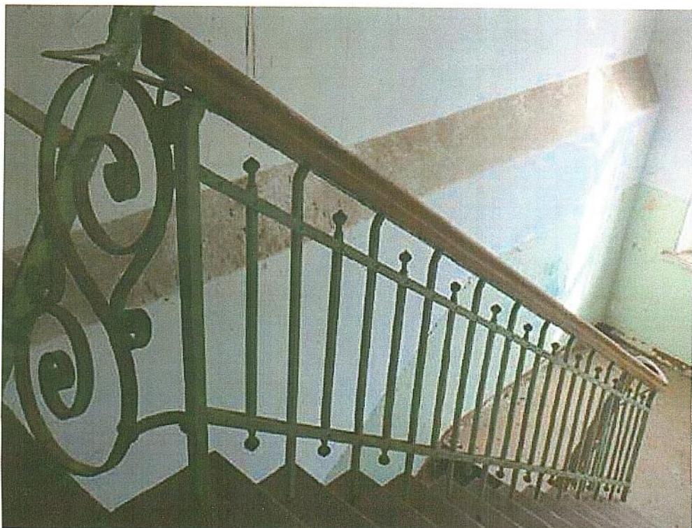
Лестница дворового корпуса здания
