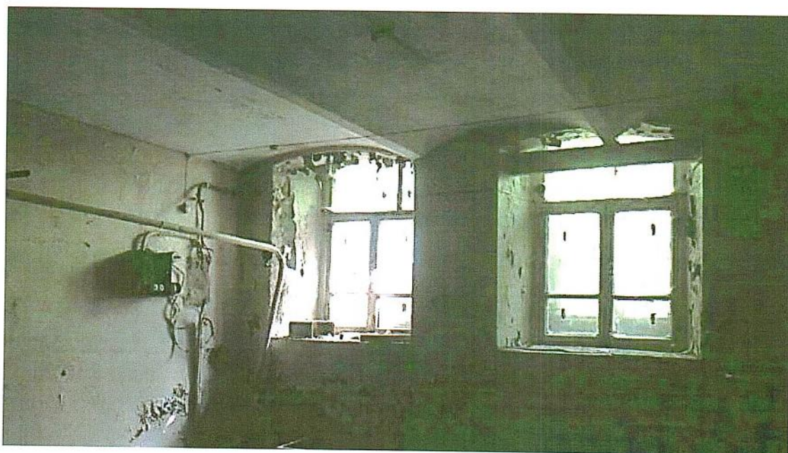
Своды Монье в подвальных помещениях
