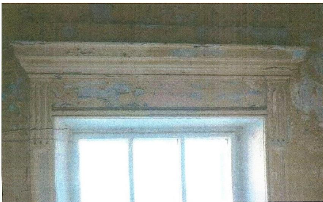
Убранство окна лестничной клетки между 2 и 3 этажами
