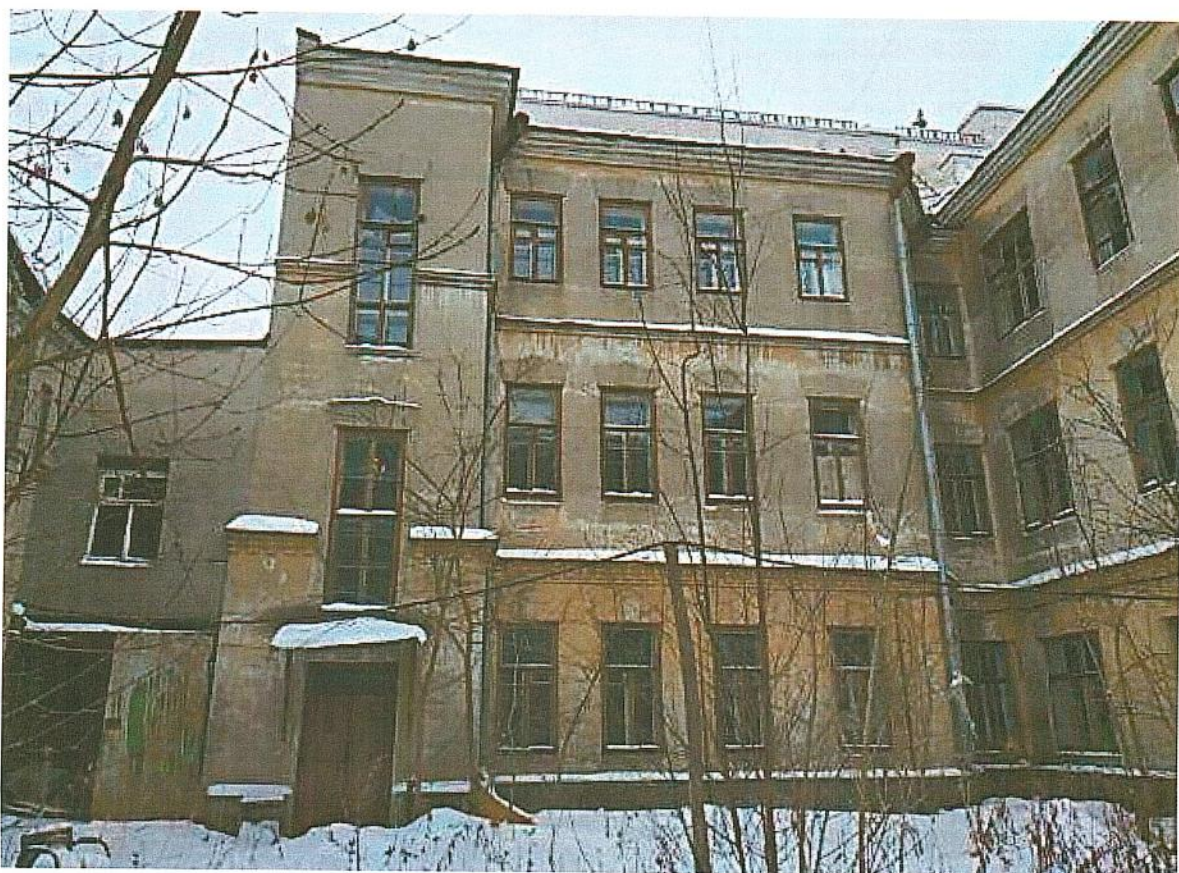
Дворовая часть здания, правое крыло
