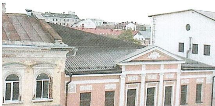
Кровля объема по ул. Баумана
