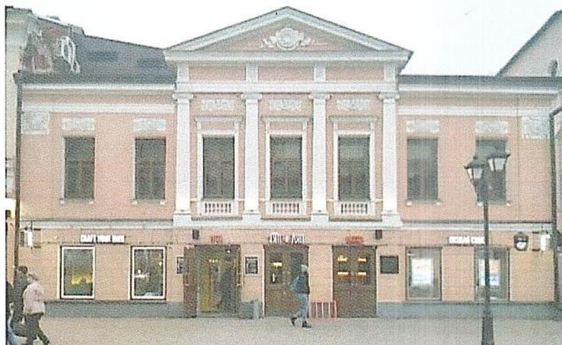
Композиция главного фасада в 7 оконных осях, акцентированного аттиком с четырьмя пилястрами и треугольным фронтоном.
