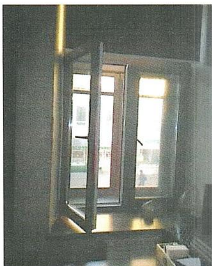
Деревянные оконные рамы
