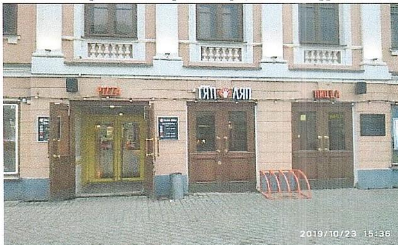
Оконные и дверные проемы прямоугольной формы, оформление первого этажа рустами с замковыми камнями над оконными и дверными проемами, балясинами в подоконных нишах 2-го этажа
