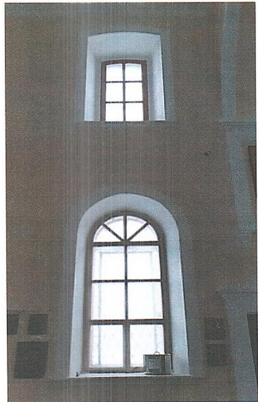
Фрагмент интерьера. Северная стена. – лучковый оконный проем – 4 шт; – полуциркульные оконные проемы (пропорции и размеры) 1-ого яруса – 6 шт.
