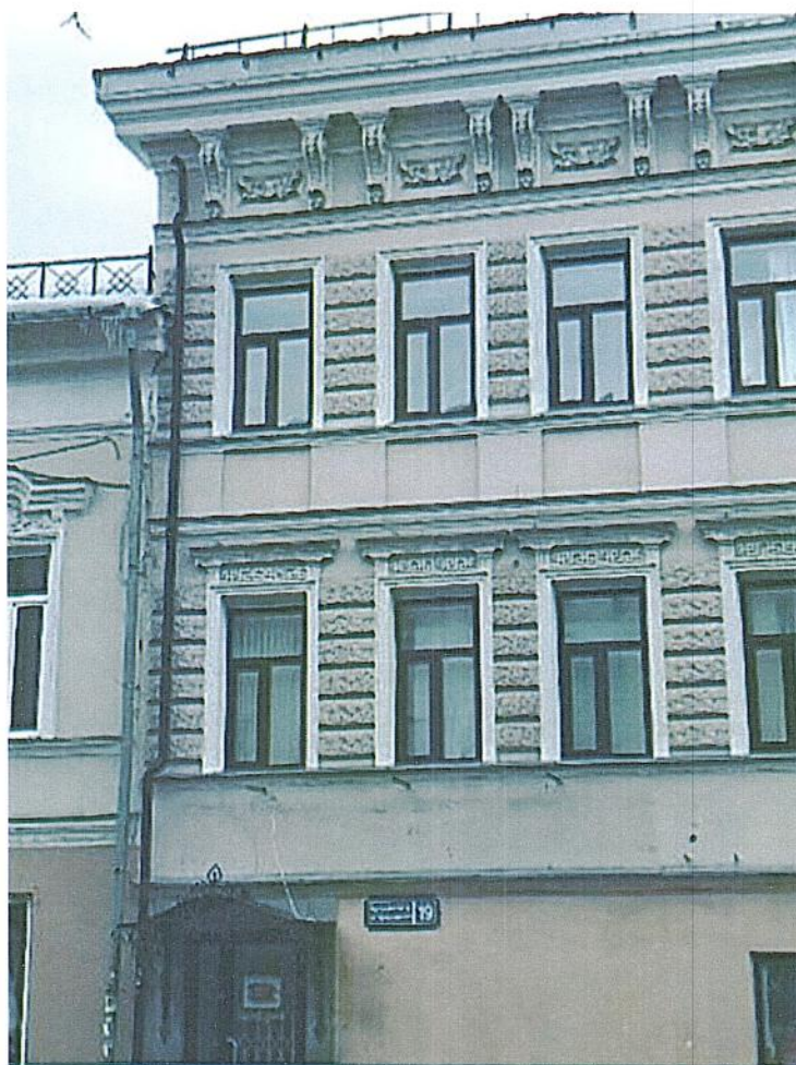
Штукатурка главного фасада, рустованная поверхность стен
