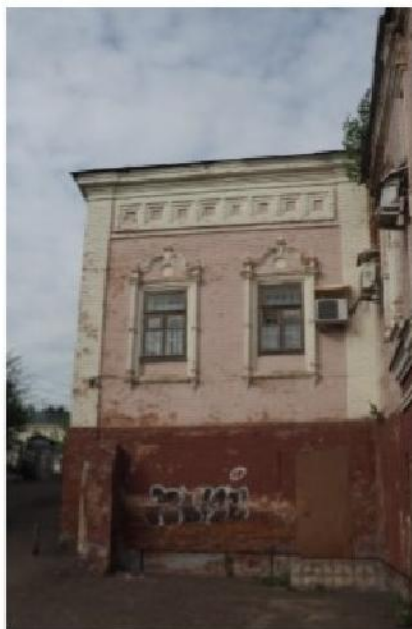
Юго-западный фасад. Фрагмент.
