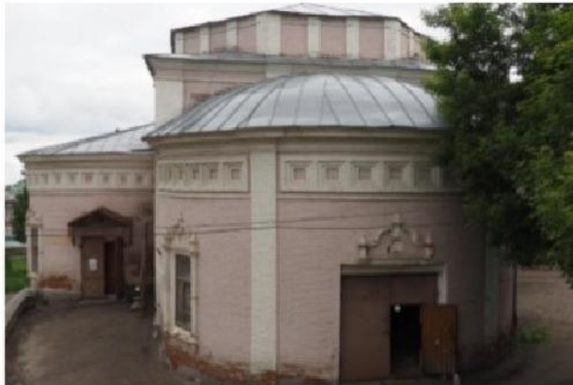
Северо-восточный фасад. Вид с северо-востока.
