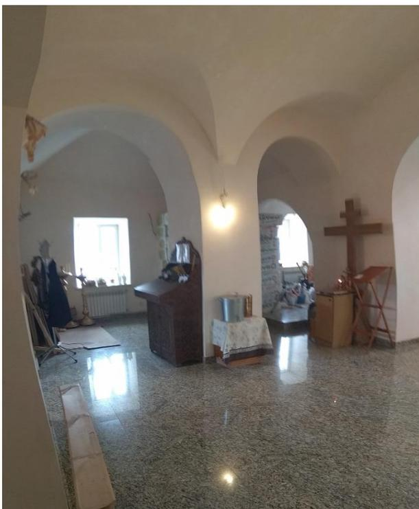
*Илл. 14. Сводчатые перекрытия, опертые на колонну. Изначально колонна была круглого сечения*
