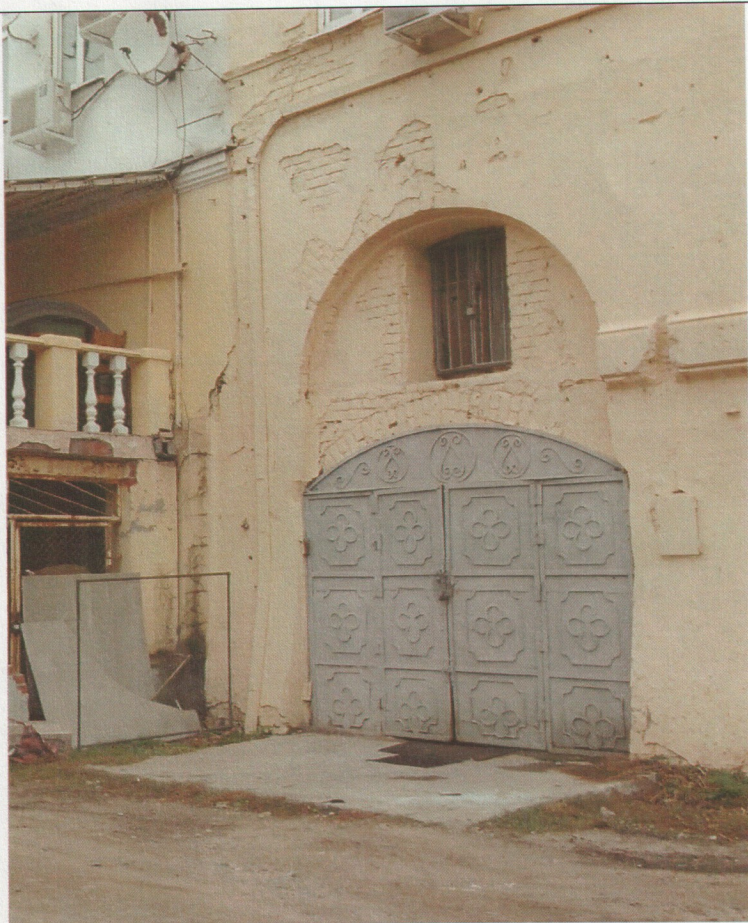
поэтажное членение здания с более высоким первым этажом в виде галереи с аркадой
