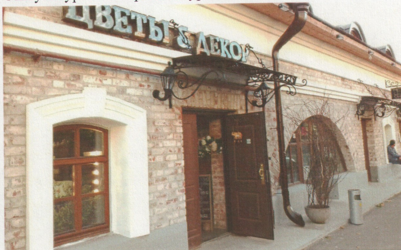
Оштукатуренные архитектурные детали
