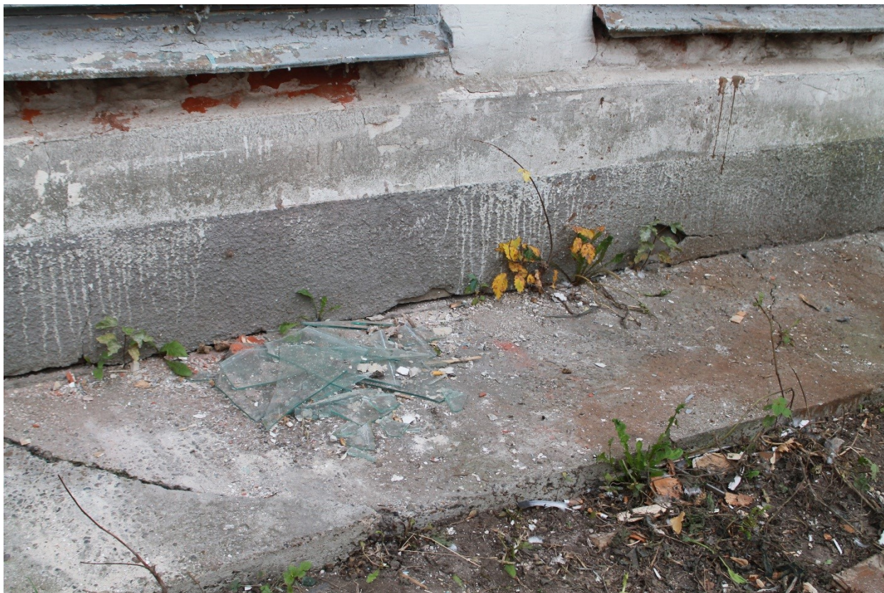
Фото 2. Фрагмент цоколя и отмостки.
