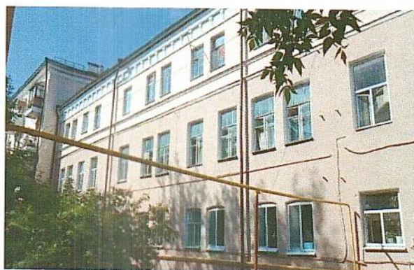
Фрагмент дворового фасада
