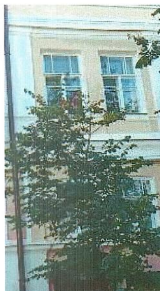
Историческая расстекловка окон третьего этажа
